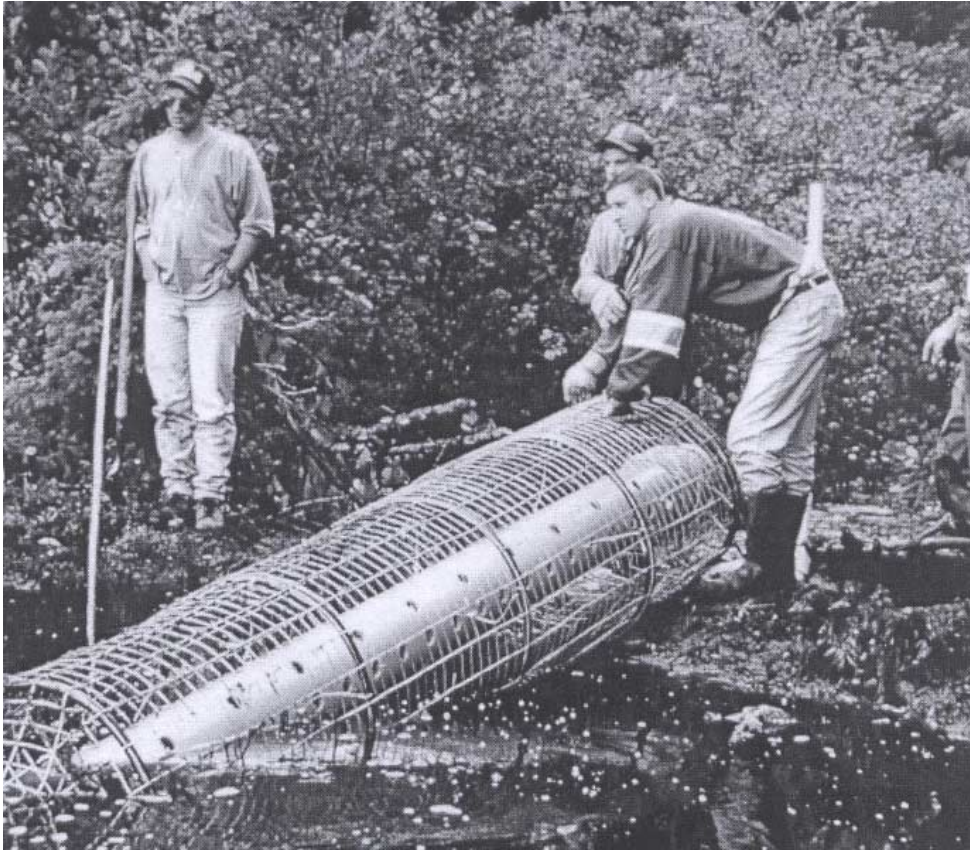
Ryc. 15. Urządzenie Clemson podczas instalacji
