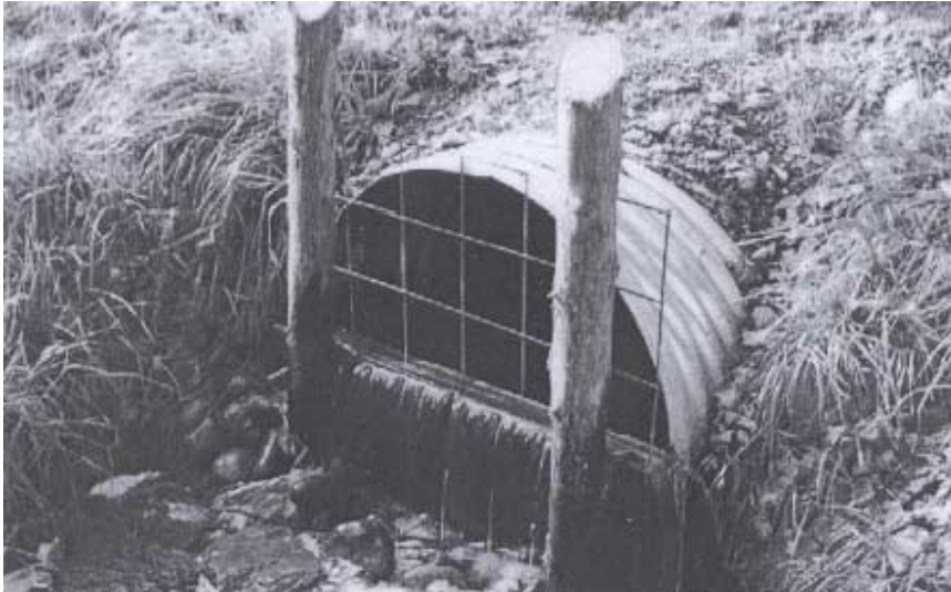
Ryc. 12. Zabezpieczenie dolnej części przepustu przed nanoszeniem materiału przez bobry.
