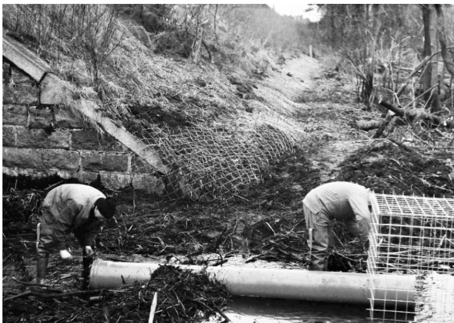
Ryc. 4. Zabezpieczenie grobli nasypu kolejowego za pomocą siatki. Jednocześnie został zabezpieczony przepust pod nasypem – rozwiązanie kompleksowe.
