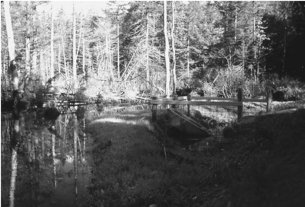
Ryc. 14. Zarośnięta tama oddalająca zabezpieczająca przepust. Zwróć uwagę na zastosowanie ogrodzenia przepustu oraz przepławkę dla ryb wbudowaną w tamę.
