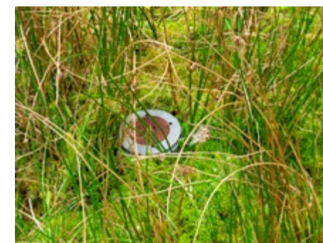
Piezometr, w którym znajduje się miernik poziomu wody. Pokrywa jest normalnie zakryta torfem.
