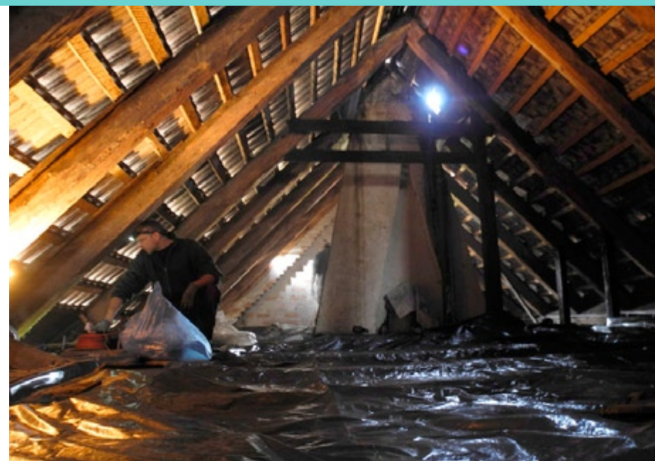
Po sprzątnięciu guana na strychu została rozłożona folia zabezpieczająca (Zielonowo)
