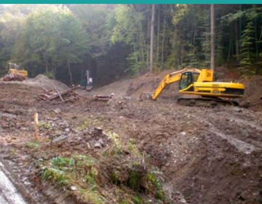
Zabudowa koryta potoku Kamionka
