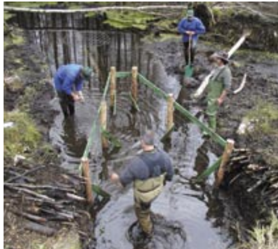
Montaż urządzenia zabezpieczającego przed atakami przez bobry przepustu pod linią kolejową
