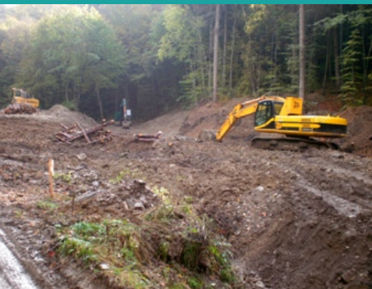
Zabudowa koryta potoku Kamionka
