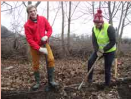
Sebastian i Marysia - jaskrawe kolory przy budowie płotku to bezpieczeństwo.
