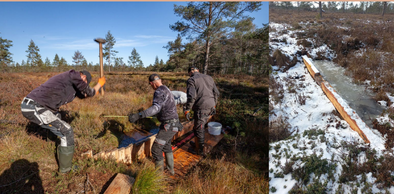
Prace przy budowie przetamowań (fot. T. Wilk)
