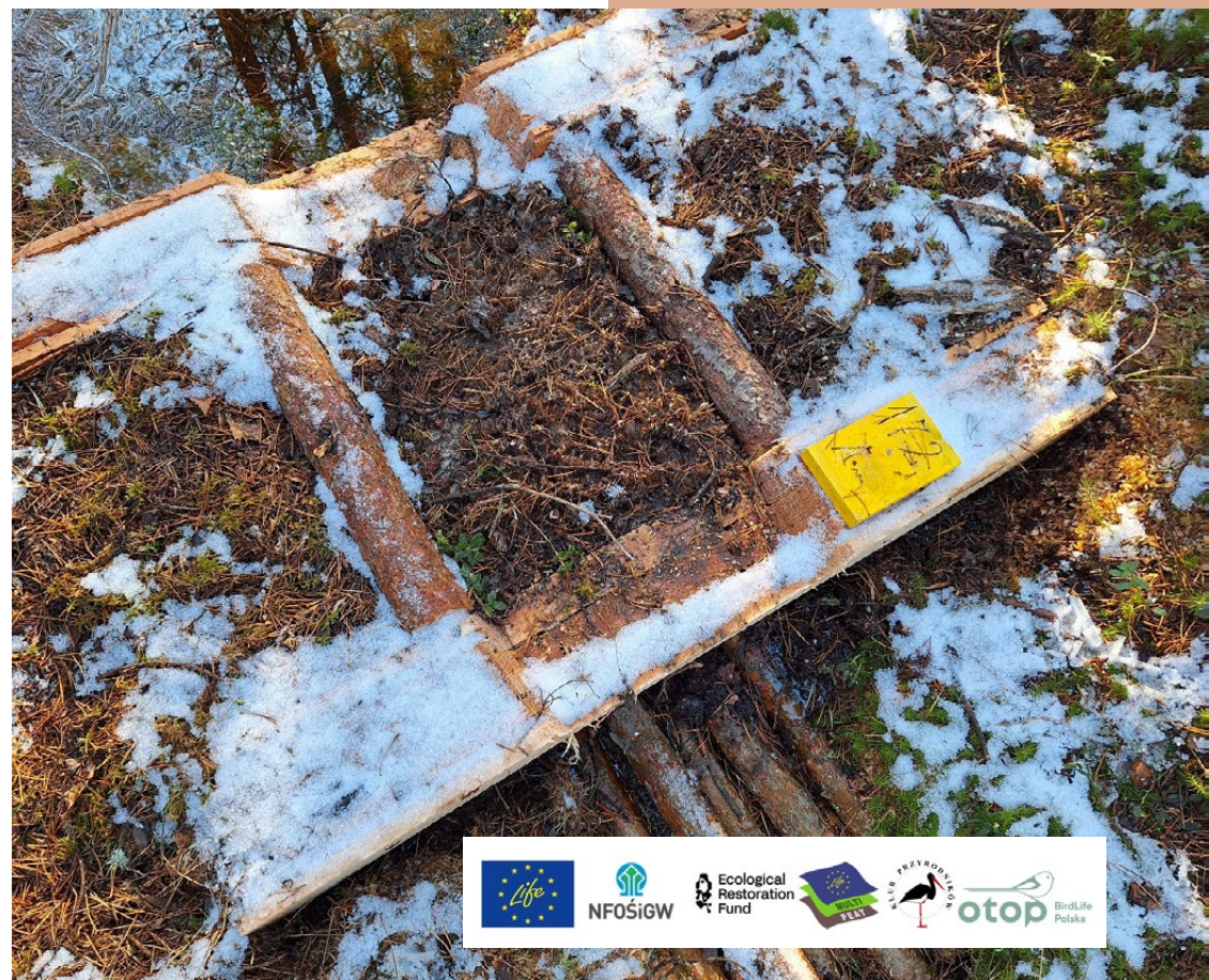
Podwójna ścianka z wypełnieniem (fot. T. Wilk)
