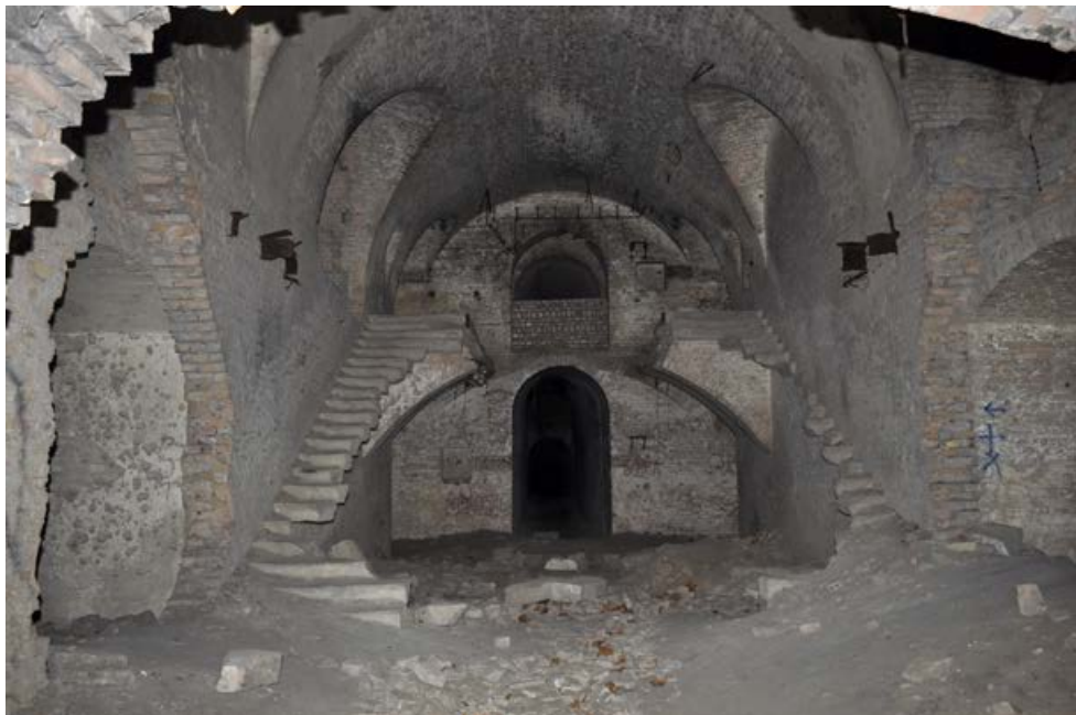
Fot. 1. Zdewastowane wnętrze Fortu Sarbinowo. Fot. W. Stephan. Photo 1. Devastated interior of Fort Sarbinowo. Photo by W. Stephan.
