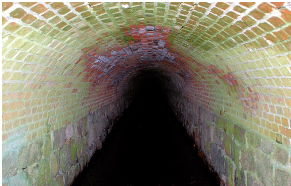
Fot. 5. Przepust w Trzciance – liczne zimowisko nocka Natterera Myotis nattereri (fot. W. Stephan). Phot. 5. Culvert in Trzcianka – site of numerous hibernation of Natterer's bat Myotis nattereri (Photo by W. Stephan).
