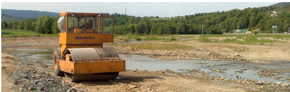
Fot. 2. Zamiast regulacji rzeki - umocnienie granicy swobodnej migracji koryta w przysiółku Pabiska - interwencje techniczne prowadzone z dala o głównego koryta Raby (fot. Józef Jeleński).
