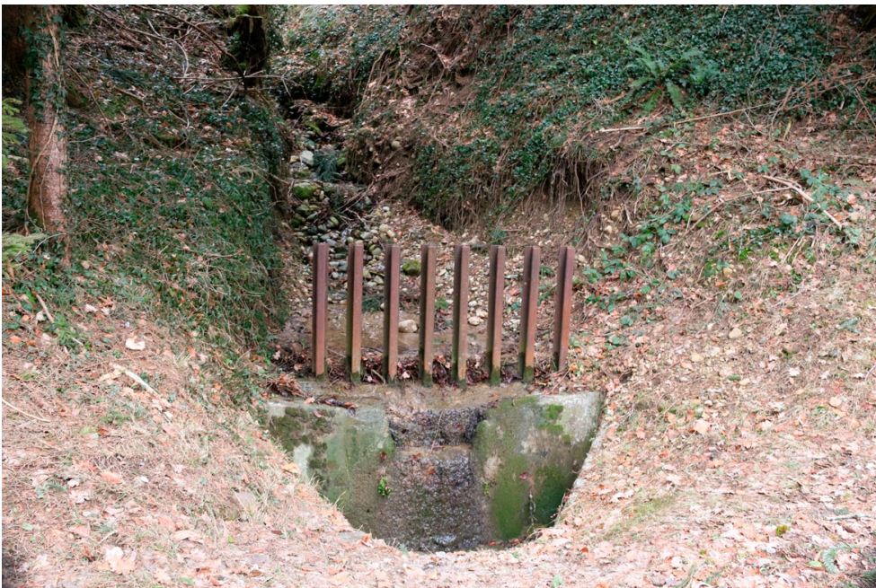
Fot. 17. „Łapacz rumoszu” przed przepustem drogowym na małym cieku leśnym. Las Bregencki, Austria (fot. Paweł Pawlaczyk).
