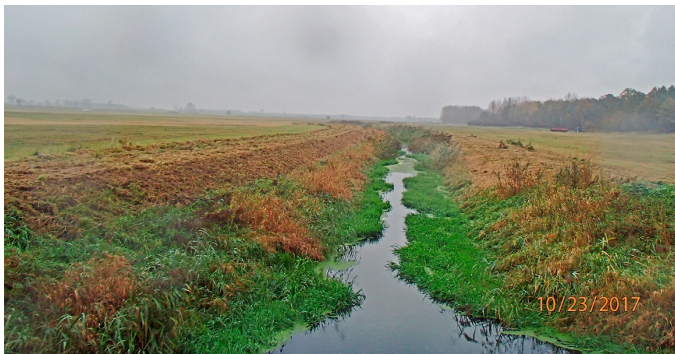
Fot. 1. Śląski Rów – widoczne wyprostowanie koryta oraz jednolita struktura roślinności (fot. M. Przesmycki).
