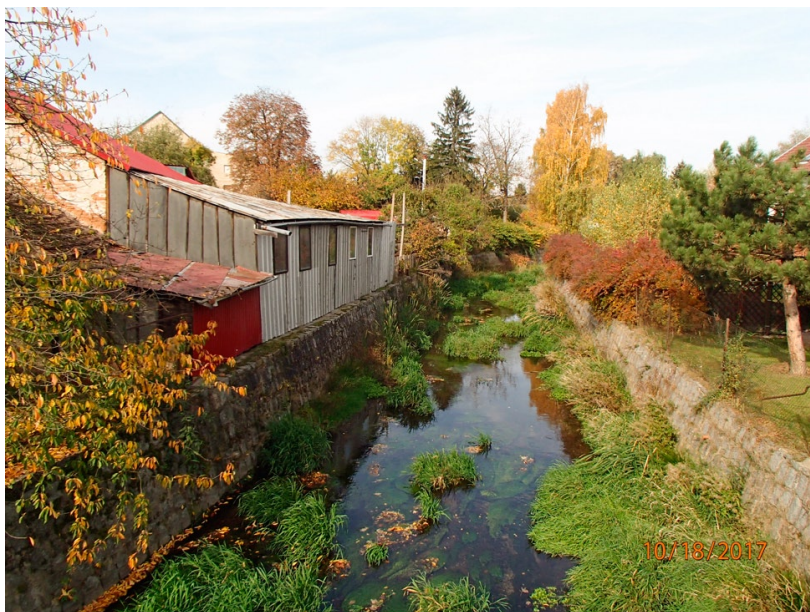
Fot. 5. Jadkowa – silnie przekształcony hydromorfologicznie ciek płynący przez tereny zurbanizowane, widoczne „ciężkie” umocnienia skarp (fot. M. Przesmycki).
