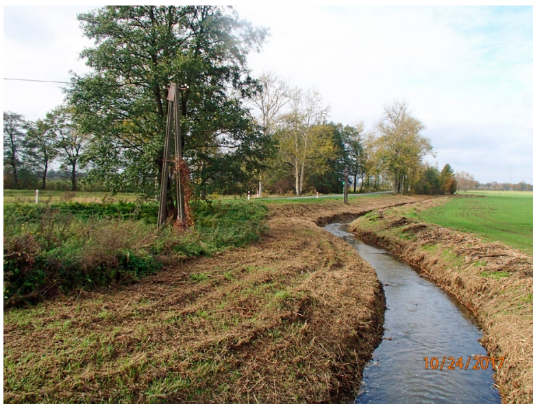
Fot. 6. Rudna – ciek po niedawno przeprowadzonych pracach konserwacyjnych, widoczny brak roślinności na skarpach brzegowych (fot. M. Przesmycki).
