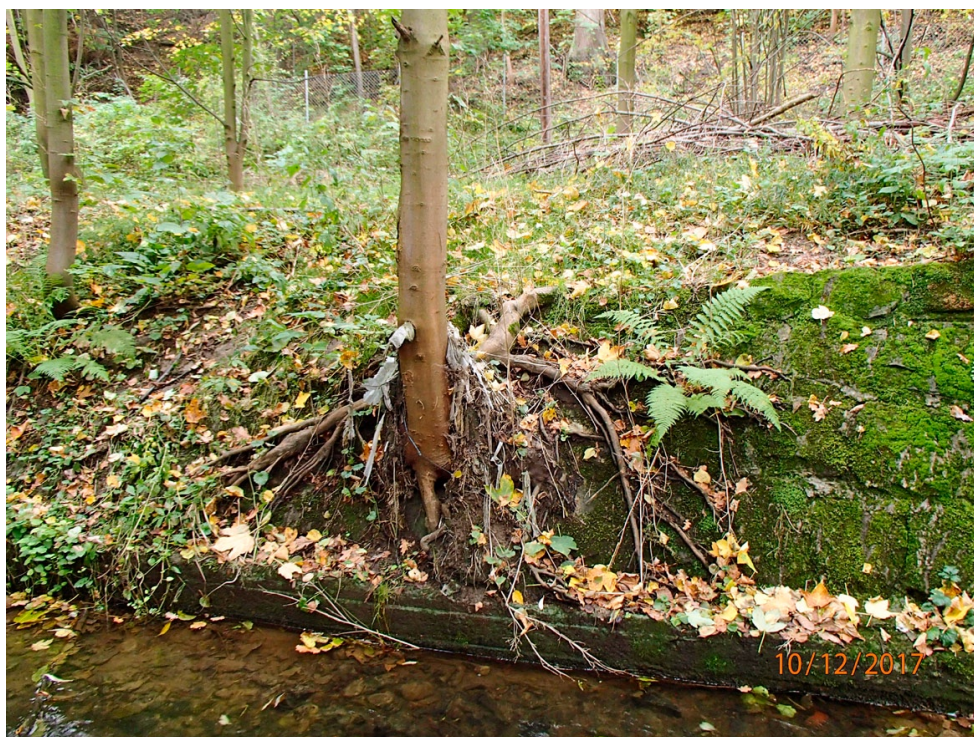
Fot. 2. Jodłówka – widoczne przerastanie umocnień brzegowych korzeniami drzew (fot. M. Przesmycki).
