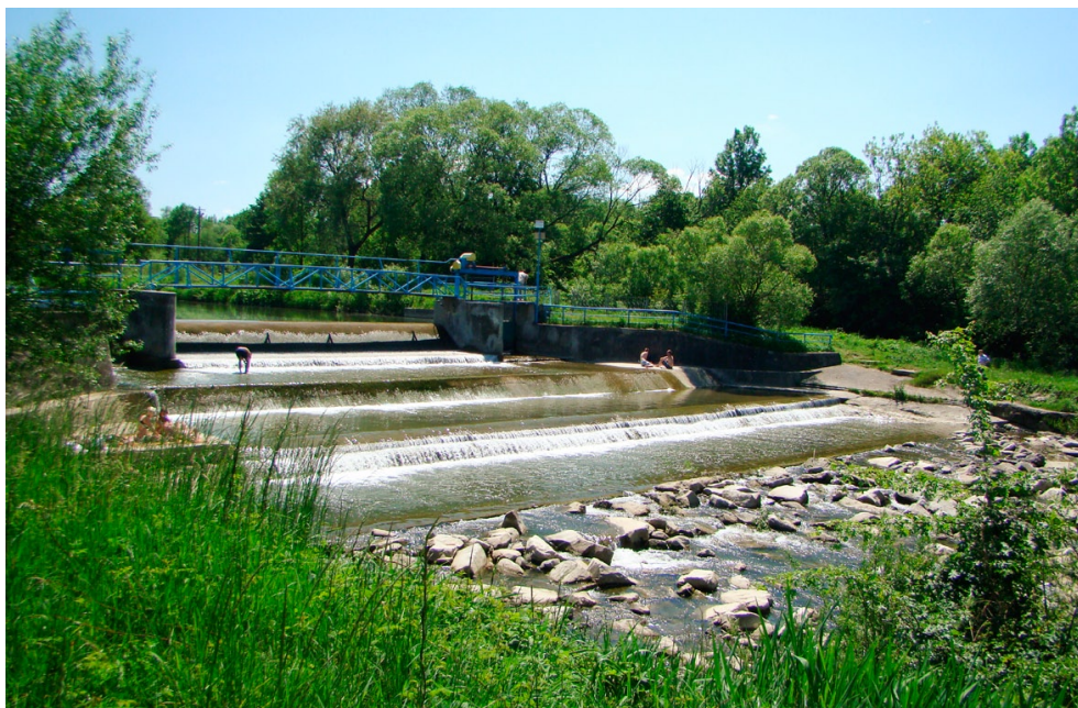
Fot. 11. Jaz ujęcia wody w m. Szczepańcowa, w km 27+960 rzeki Jasiołki (fot. Marek Jelonek).
