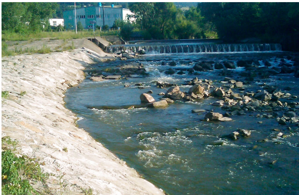
Fot. 14. Stopień ujęcia wody w m. Ropica Polska, w km 39+400 rzeki Ropy (fot. Piotr Sobieszczyk).
