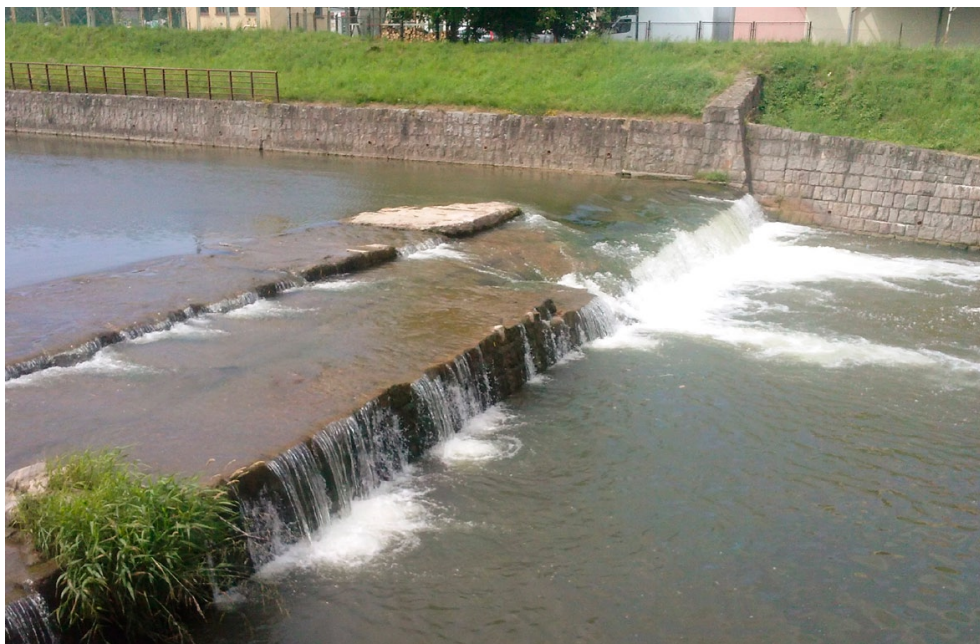
Fot. 13. Stopień w Gorlicach, w km 34+250 rzeki Ropy (fot. Piotr Sobieszczyk).
