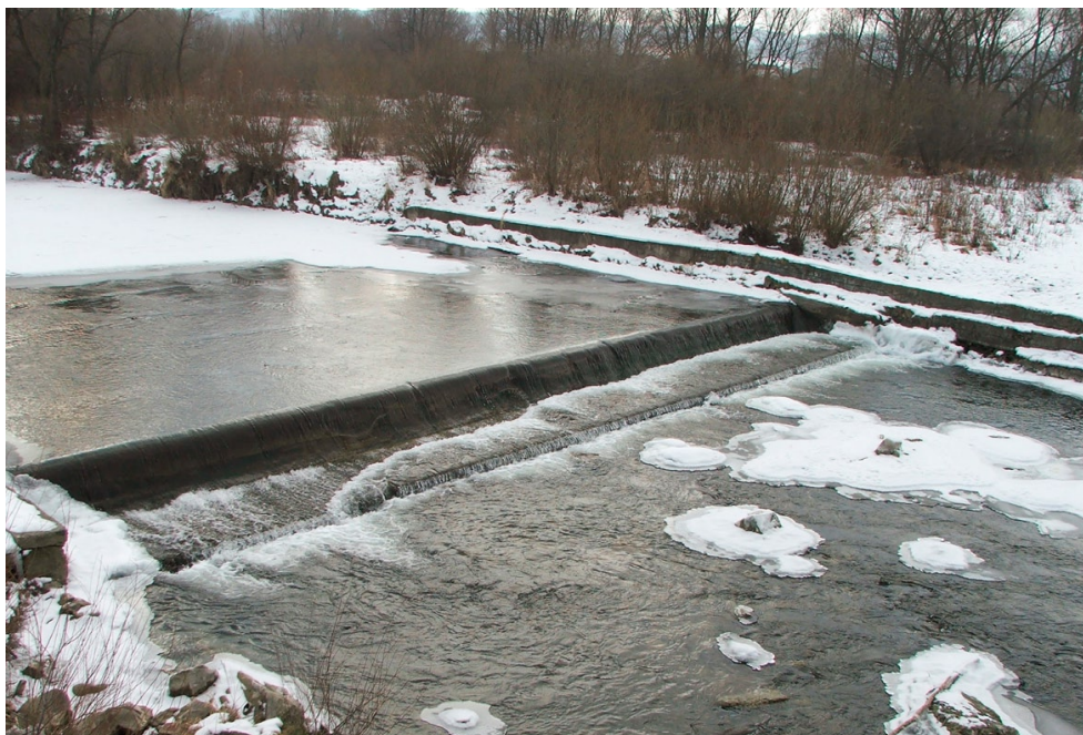
Fot. 10. Próg betonowy w m. Jedlicze, w km 19+100 rzeki Jasiołka (fot. Piotr Sobieszczyk). Photo 10. Concrete weir at km 19.100 of the Jasiołka River in Jedlicze (photo by Piotr Sobieszczyk).
