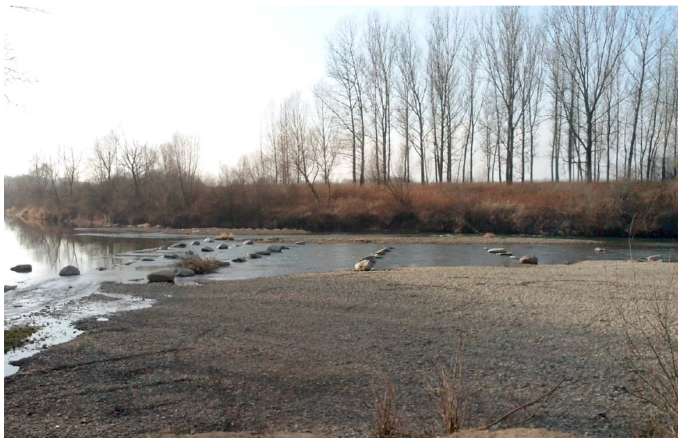
Fot. 18. Ułożenie ażurowe głazów na stanowisku nr 5 przy ujściu rzeki Ostra (fot. Piotr Sobieszczyk).
