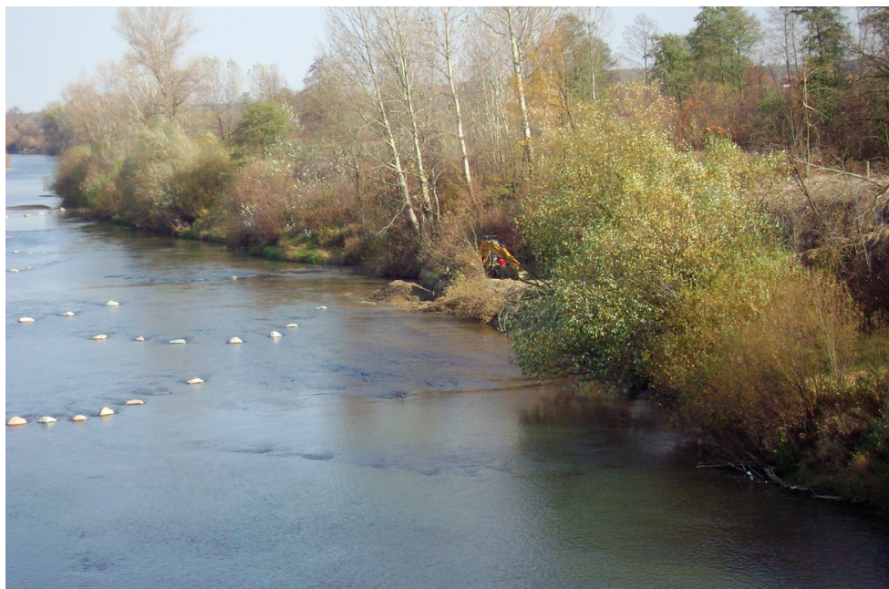
Fot. 17. Deflektory ażurowe na stanowisku 10 poniżej mostu w Brzeźnicy (fot. arch. Algebar).
