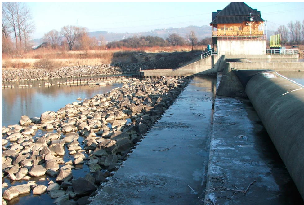
Fot. 8 Jaz powłokowy w m. Mokrzec, w km 69+720 rzeki Wisłoki (fot. Piotr Sobieszczyk).
