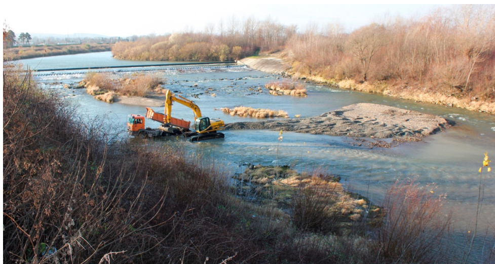
Fot. 15. Alimentacja żwiru na stanowisku nr 6 poniżej stopnia w Dębicy (fot. arch. Wodnik).
