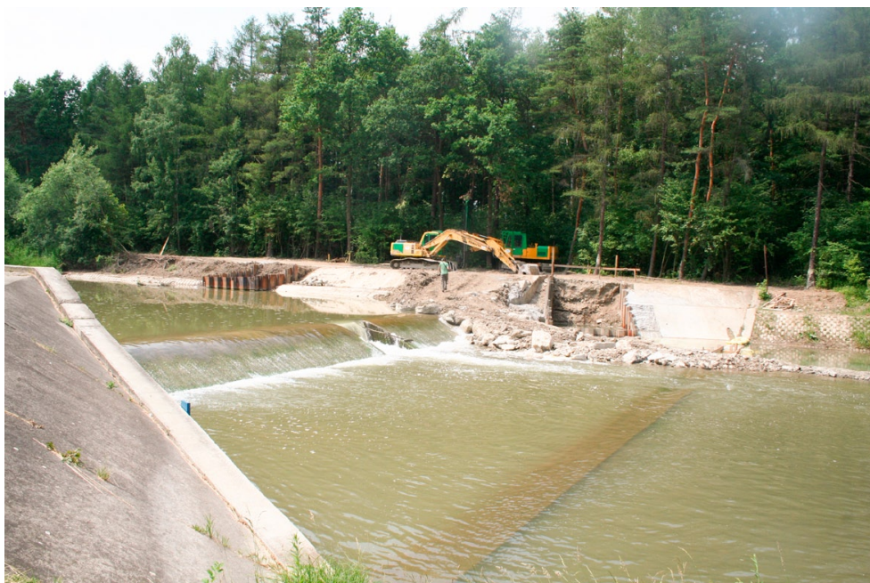
Fot. 2. Stopień w km 108+080 w miejscowości Jasło, w trakcie przebudowy (fot. Piotr Sobieszczyk). Photo 2. The weir at km 108.080 in Jasło, during reconstruction (photo by Piotr Sobieszczyk).
