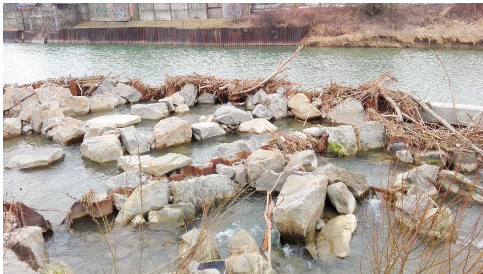
Fot. 5. Zatkane po przejściu wielkich wód otwory wlotowe do przepławki przy stopniu w km 107+200 Wisłoki w miejscowości Jasło (fot. Piotr Sobieszczyk).
