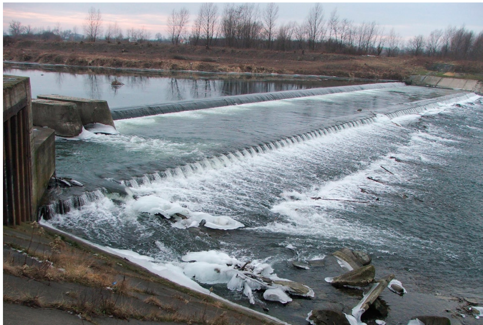
Fot. 7 Stopień w m. Dębica, w km 56+180 rzeki Wisłoki (fot. Piotr Sobieszczyk).
