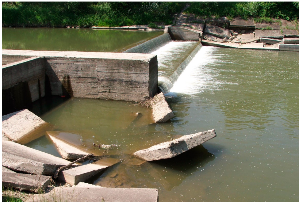
Fot. 1. Stopień w km 107+200 w miejscowości Jasło przed rozpoczęciem Projektu (fot. Piotr Sobieszczyk). Photo 1. The weir at km 107.200 in Jasło before the project (photo by Piotr Sobieszczyk).
