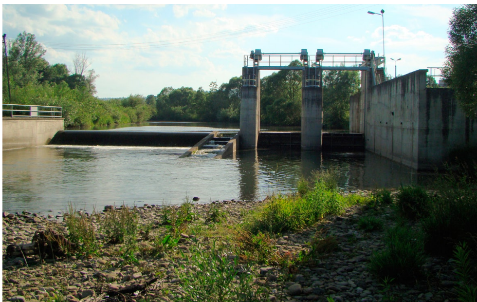
Fot. 12. Jaz stały z sekcją ruchomą w m. Gorlice, w km 32+300 rzeki Ropy (fot. Piotr Sobieszczyk).
