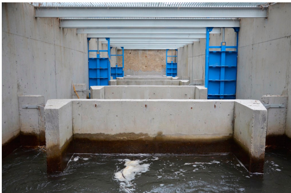
Fot. 4. „Wnętrze” przepławki dwuszczelinowej przy stopniu w km 108+080 Wisłoki w miejscowości Jasło (fot. Piotr Sobieszczyk). Photo 4. Double-jet vertical slot fish pass by the weir at km 108.080 of the Wisłoka River in Jasło (photo by Piotr Sobieszczyk).
