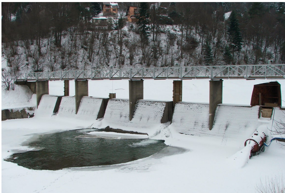
Fot. 9. Jaz w m. Krempna, w km 145+230 rzeki Wisłoki (fot. Piotr Sobieszczyk). Photo 9. The weir at km 145.230 of the Wisłoka River in Krempna (photo by Piotr Sobieszczyk).
