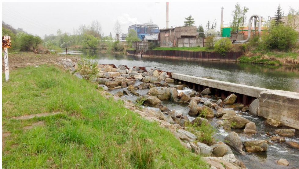
Fot. 3. Bystrotok przy stopniu w km 107+200 Wisłoki w miejscowości Jasło (fot. Piotr Sobieszczyk). Photo 3. Rock-ramp by the weir at km 107.200 of the Wisłoka River in Jasło (photo by P. Sobieszczyk).
