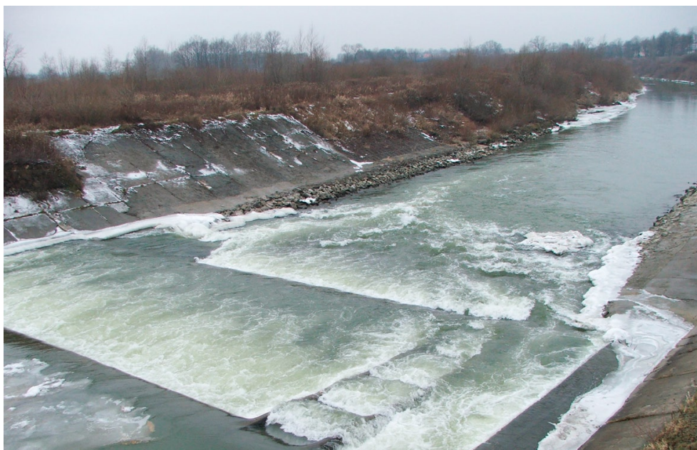
Fot. 6. Stopień ujęcia wody w m. Mielec, w km 21+500 rzeki Wisłoki (fot. Piotr Sobieszczyk).
