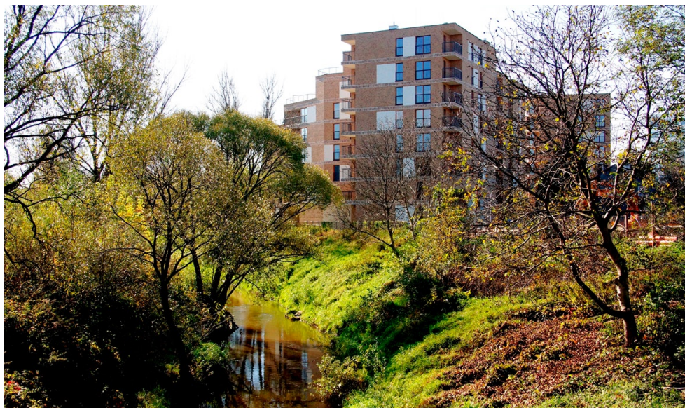
Fot. 1. Zabudowa wielorodzinna sięga po same skarpy brzegów rzeki Wilgi w Krakowie (fot. Kazimierz Walasz).
