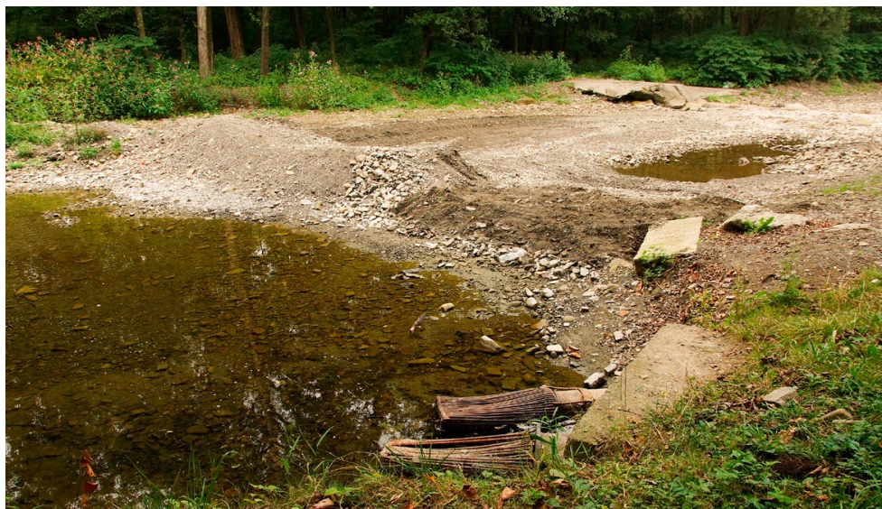
Fot. 2. Ujęcie wody na rzece Wieprzówce. W okresie niżówek zabiera całą wodę z rzeki (fot. Kazimierz Walaś).
