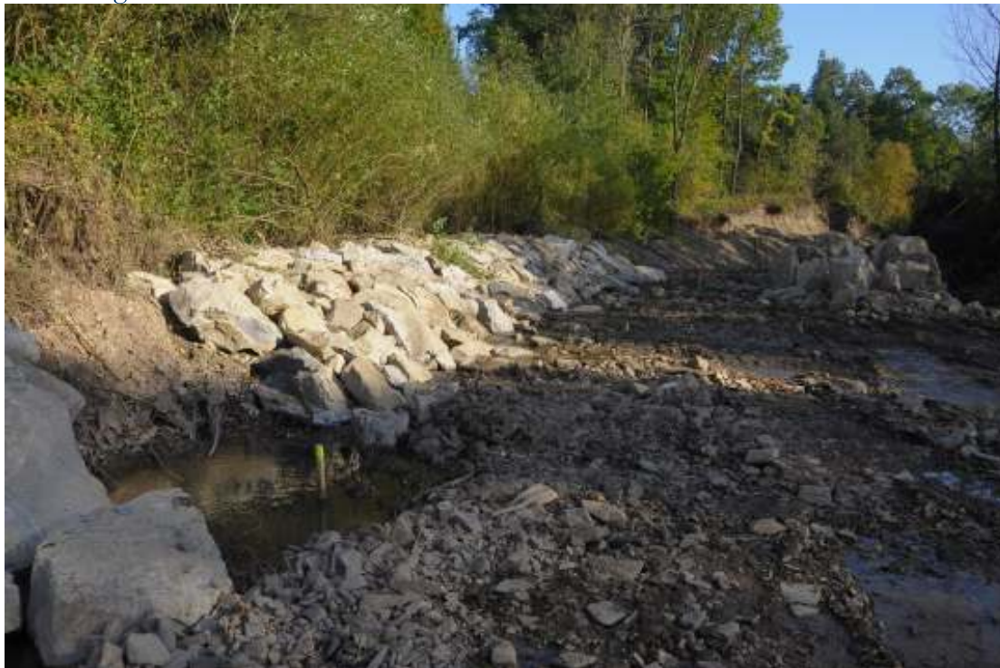
Jasieniczanka – roboty od km 0+000 w górę potoku. De facto wytyczenie nowej trasy regulacyjnej na odcinku bez zabudowy i pól uprawnych.
